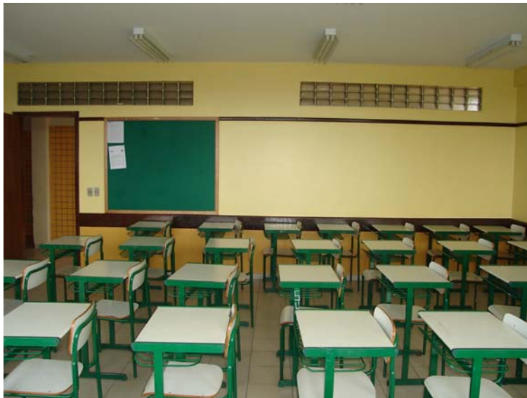
FIGURA 38 – DETALHE – FAIXAS DE TIJOLOS DE VIDRO NA SALA DE AULA
